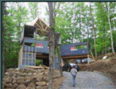
Il a donc conçu un système d'assemblage qui permet l'utilisation de conteneurs à la fois comme fondation, moyen de transport et entreposage durant le chantier. De ce fait il maximise leurs utilisations. Certains conteneurs sont inversés c'est-à-dire le plancher au plafond (l'érection se fait donc à l'envers) et dans certains designs on peut les retrouver debout.
